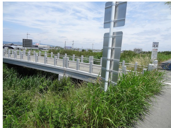
04.橋脚、桁、高欄全て塗装されて リニューアル
